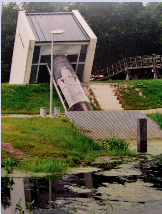
Polderschöpfwerk Leek (NL)
