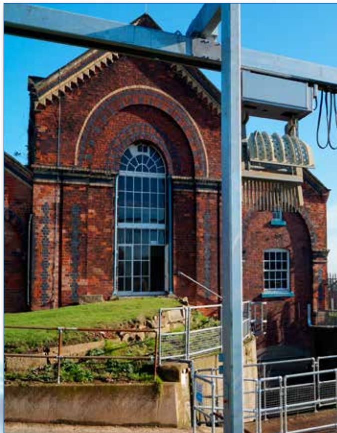
Gemaal met LANDY roosterreiniger
