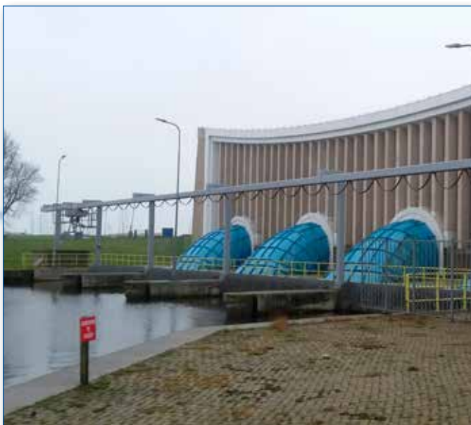
Renovatie Hoogland gemaal Stavoren
